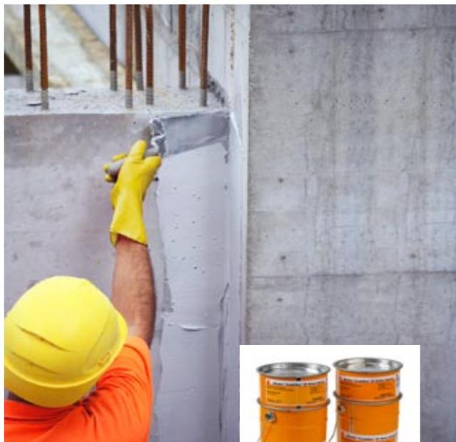
Per ottenere una coesione impermeabile e permanente tra il nastro **Sikadur-Combiflex® SG** e il sottofondo si impiegano gli adesivi **Sikadur®**.
